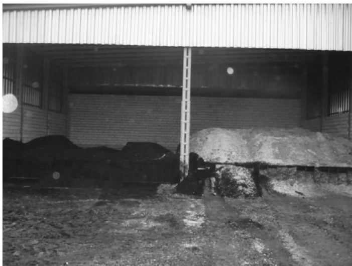
Рис.4. Склад кородревесных отходов
