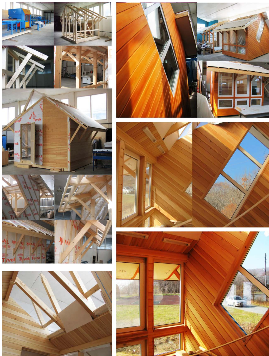
Рис. 3. Процесс сборки экомодуля Solar-5М в Технопарке ДВФУ/ДВГТУ
