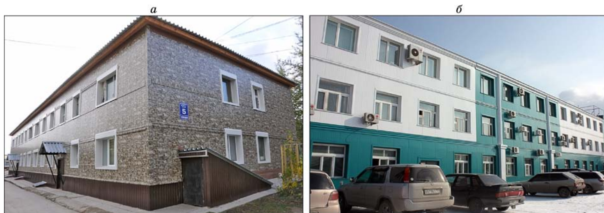
Рис. 15. Жилые дома после утепления теплоизоляционными панелями с вентилируемыми каналами: а) г. Искитим, б) пос. Петровский Новосибирской области.
