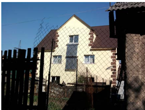
Рис. 8. Размещение вакуумного солнечного коллектора на южном фасаде жилого дома.
