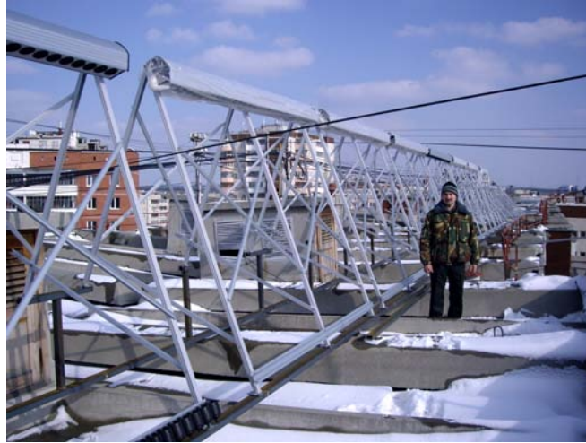
Рис. 3 . Фото монтажа каркаса для солнечных вакуумных коллекторов на многоквартирном доме в Екатеринбурге (март, 2012 г.)
