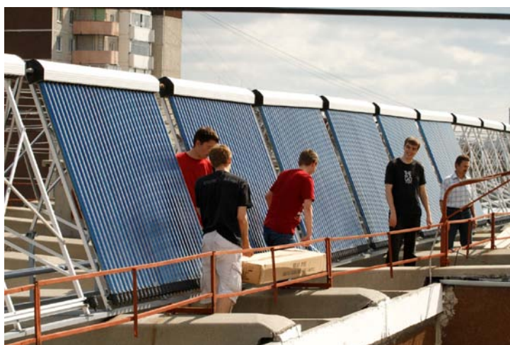
Рис. 7. Монтаж вакуумных солнечных коллекторов на многоквартирном 10-ти этажном доме в Екатеринбурге (июнь 2012г., студенты кафедры АС и ВИЭ УрФУ на практическом занятии по монтажу. Руководитель – доц.В.И. Велькин)
