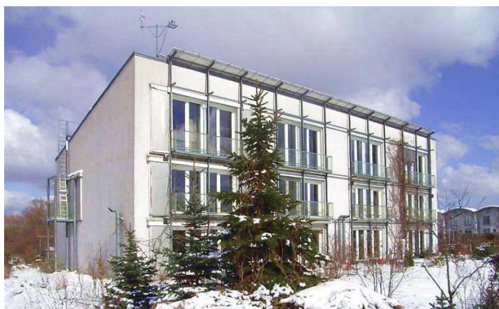
Рис. 1. Энергопассивный дом, г. Дармштадт.
