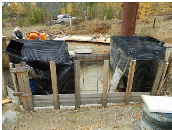
Бетонирование основания под водяные ёмкости
