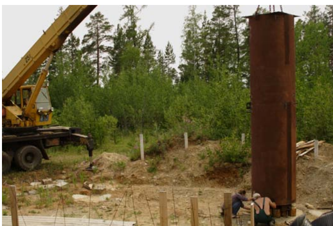
Монтаж теплового бака-аккумулятора
