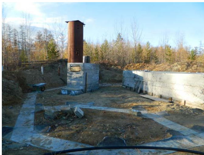
Основание цокольного этажа
