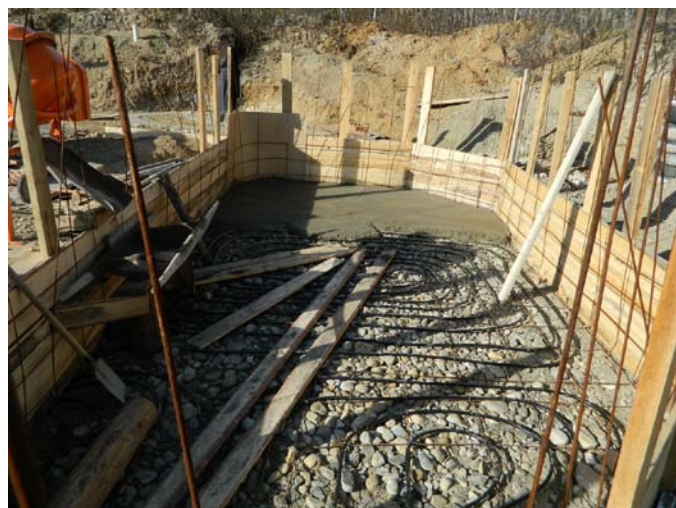
Бетонирование основания под водяные ёмкости
