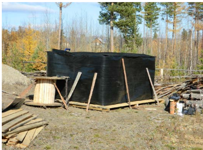
Сварка оболочки ёмкости 20 м 3
