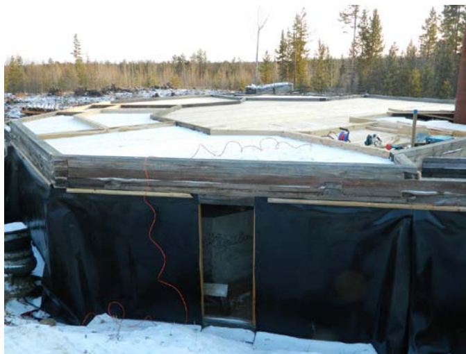
Гидроизоляция и перекрытие цокольного этажа
