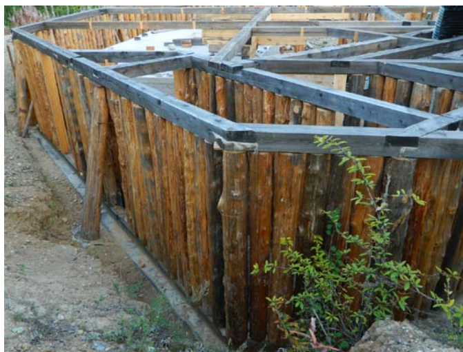
Стены цокольного этажа
