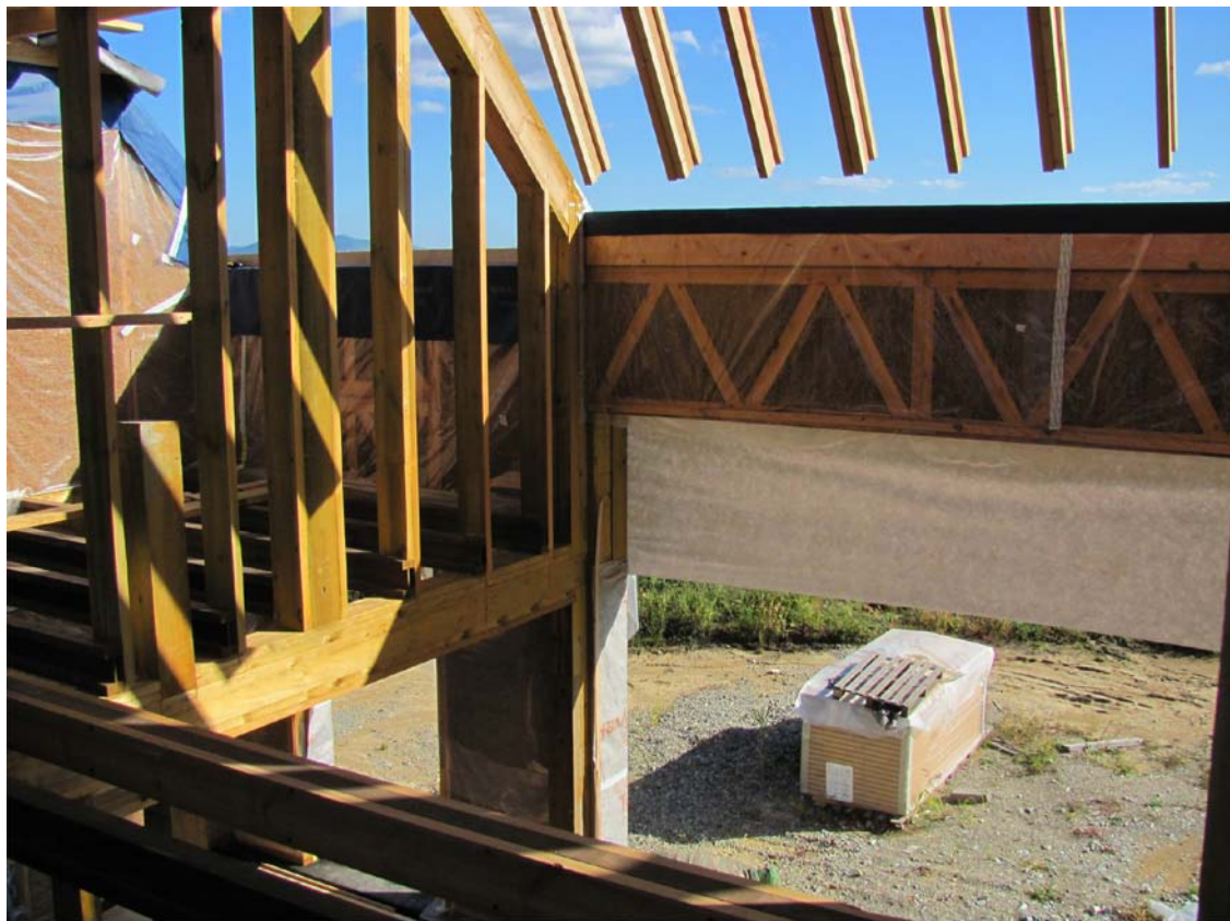
Рис. 12. Индивидуальный жилой дом Solar-Sb: вид атриума осенью 2014 г.
