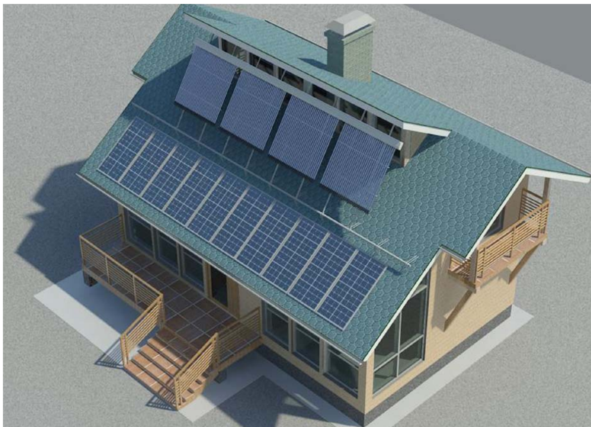
Рис.2. Проект социального индивидуального жилого солнечного дома повторного применения на семью из 4 человек – «Экодом Solar-S». Общая площадь 75 кв.м., доля пассивного солнечного отопления в условиях юга Приморья – до 35 - 40%. Проектная компания М-Арк, Павел Казанцев, Елена Кялунзига, 2010 г.
