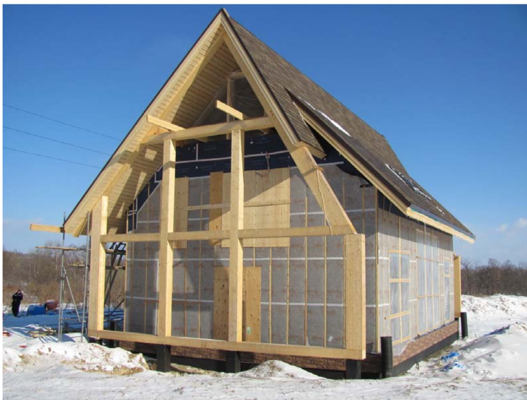
Рис. 10. Индивидуальный жилой домSolar-Sb: проектный вид и вид строящегося здания зимой 2015 г.
