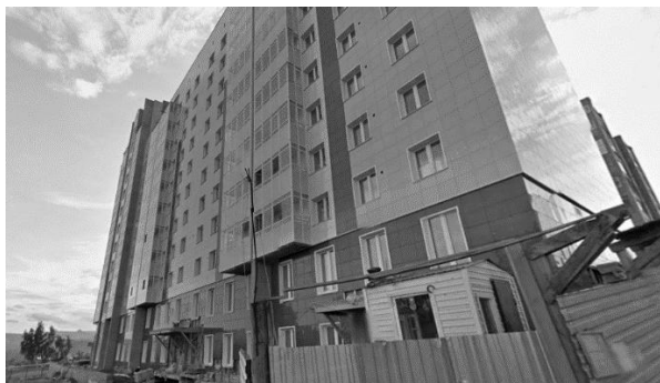
Рис. 8. Дом с повышенным тепловой защитой. ул. Волочаевская д. 11а.
