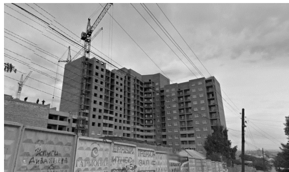
Рис. 9. Строящийся дом с повышенной тепловой защитой.
