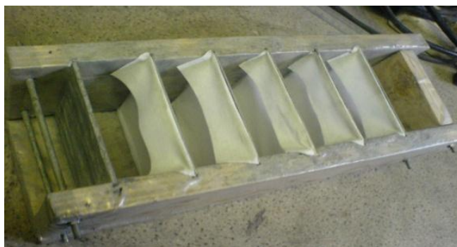
Рис.3 Общий вид деревянной опалубки
