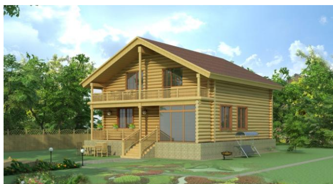
Рис. 7. Жилое здание Азовского ННМР Омской области
