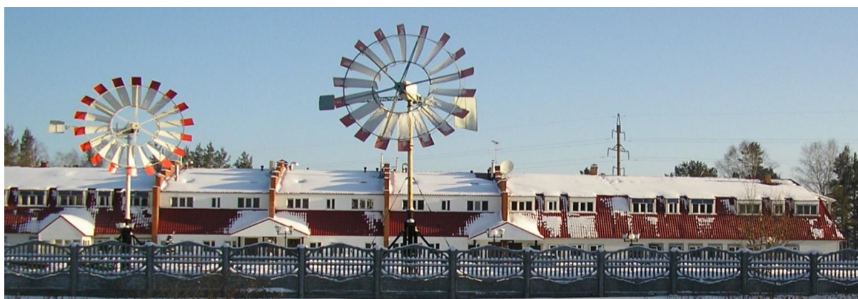
Рис. 8. Реконструированный объект «Энергоэффективный дом» с комплексом возобновляемых источников энергии (январь 2015 г.)
