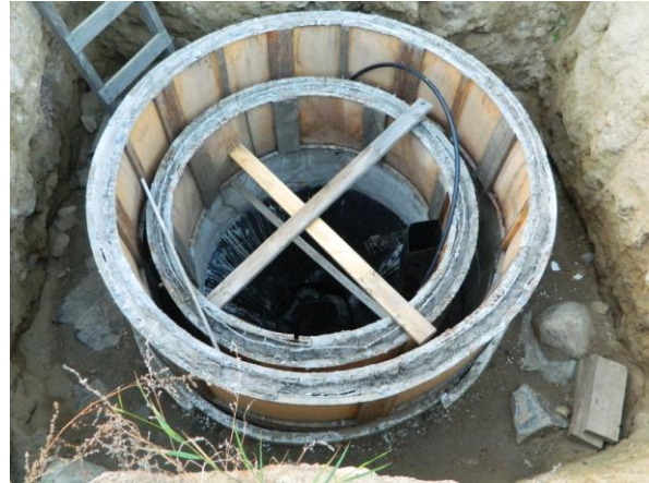
Строительство локальной очистной установки «Поплавок». г. Северобайкальск 2016 г.
