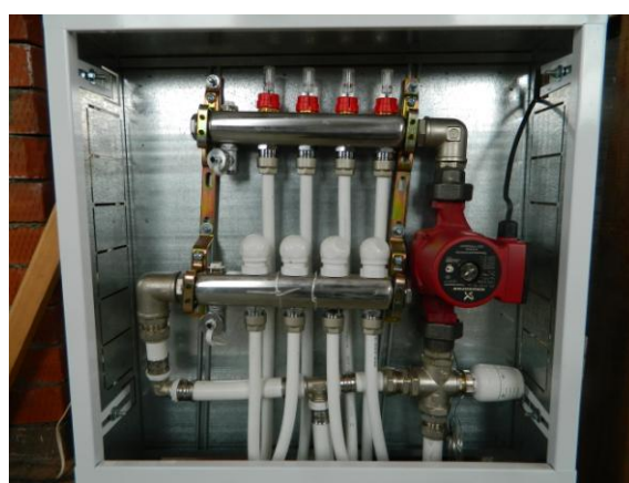
Узел управления «тёплым полом»
