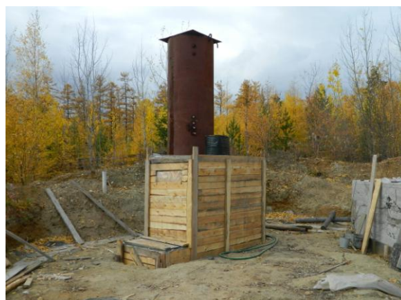
Бетонирование биотуалета "Clivus Multrum" 2013 г.
