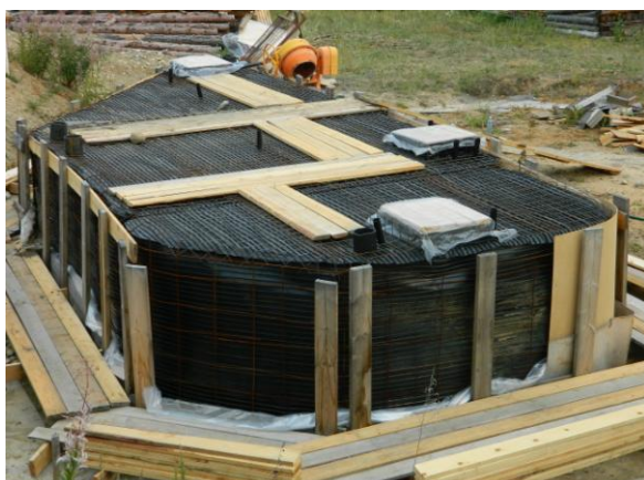
Перед бетонированием водяных ёмкостей дома «нулевого потребления» 2013 г.
