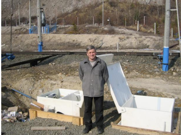
Монтаж очистной установки на Северомуйском тоннеле 2008 г.
