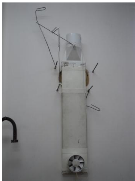
Рис. 8. ДПВСВ НПП «Пневмакс», установленный для проведения испытаний (вид из помещения)
