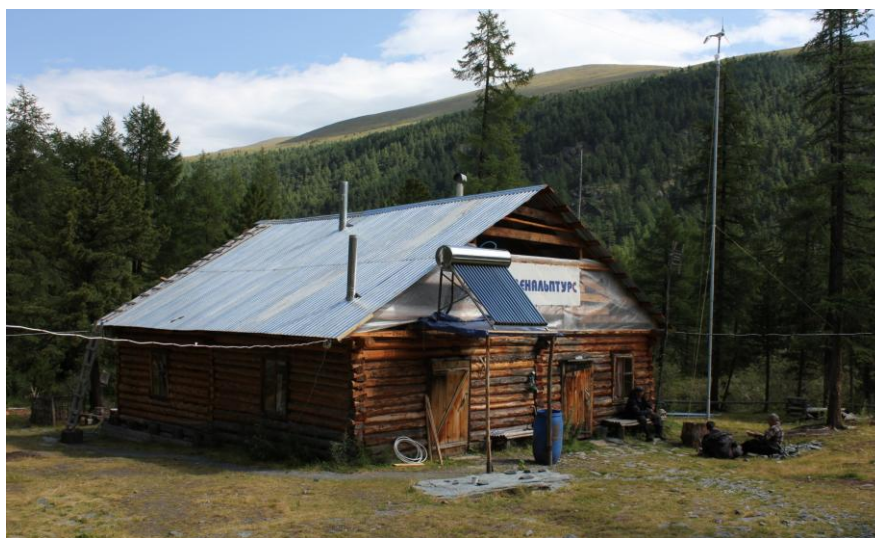
Рис. 2. Солнечный коллектор на турбазе «Высотник»
