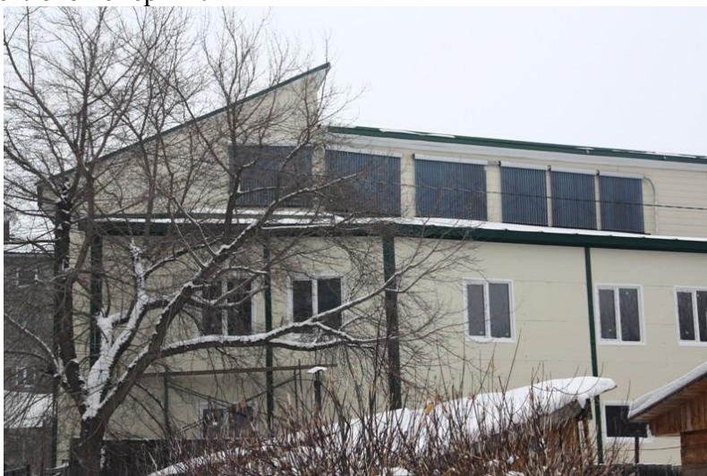
Рис. 9. Установка солнечных коллекторов на фасаде здания.
