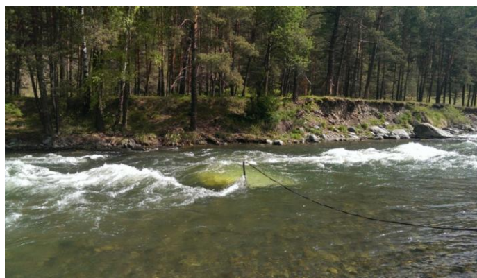
Рис. 5. Бесплотинная ГЭС в потоке воды
