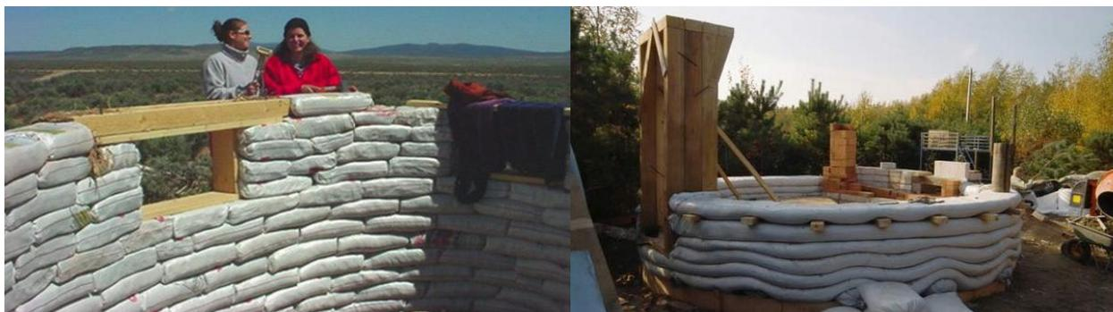
Рис. 2.5.1. Строительство экодому из мешков с утрамбованной землей.
