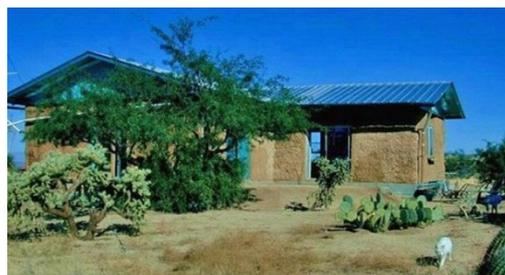
Рис. 2.3.1. Бескаркасное строительство экодому из соломы.
