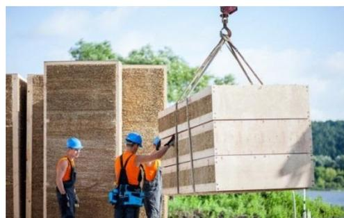
Рис. 2.3.3. Сборка дома из панелей с соломенным утеплителем.
