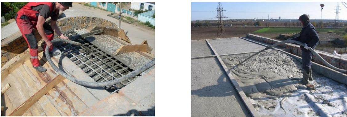
Рис. 3.1.9. Заливка плиты фибропенобетоном на профильной крыше и плоской плиты под холодным чердаком.
