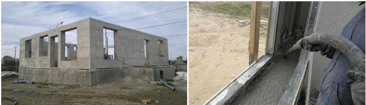
Рис. 3.1.8. Строительство стен из монолитного фибробетона.
