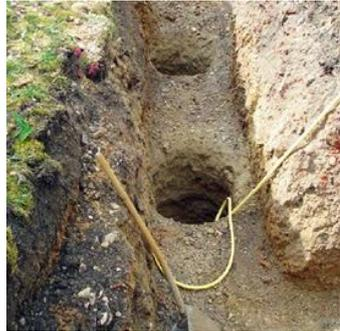
Рис. 3.1.5. Скважина для подачи воды.
