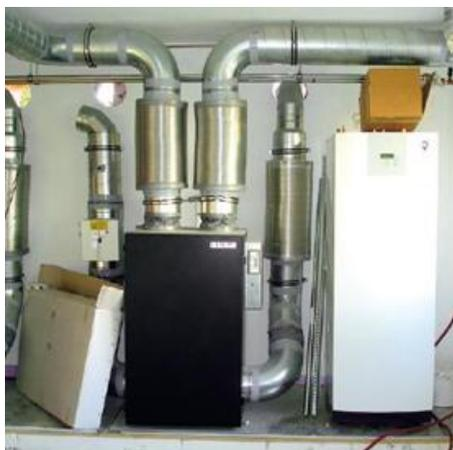
Рис. 3.1.11. Вентиляционная система с рекуперацией.
