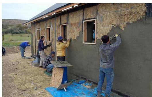
Рис. 2.3.2. Каркасное строительство экодому из соломы.
