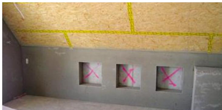
Рис. 3.1.7. Герметизация стыков клейкой лентой.
