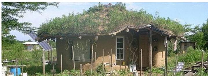
Рис. 2.1.1. Экодома на фундаменте из необработанных камней и с травяной крышей.
