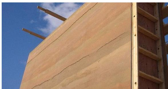
Рис. 2.4.2 Строительство стены дома из утрамбованной земли.
