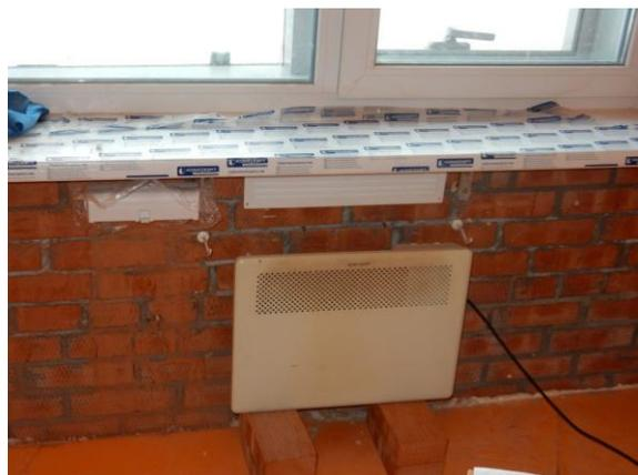
Рис. 5. Клапаны ЗАО «БФК» и «Домовент- Оптима», установленные под окном.
