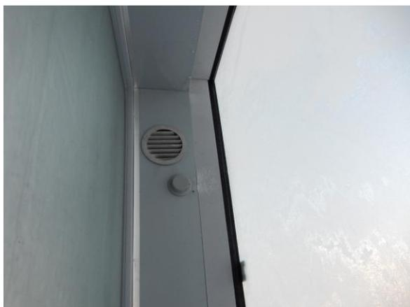
Рис. 2. Входы стеновых воздушных приточных клапанов, расположенные в межоконном пространстве.
