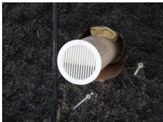
Рис. 7. ДПВСВ НПП «Пневмакс», установленный для проведения испытаний (вид с улицы)
