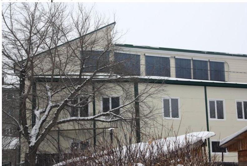
Рис. 9. Установка солнечных коллекторов на фасаде здания.
