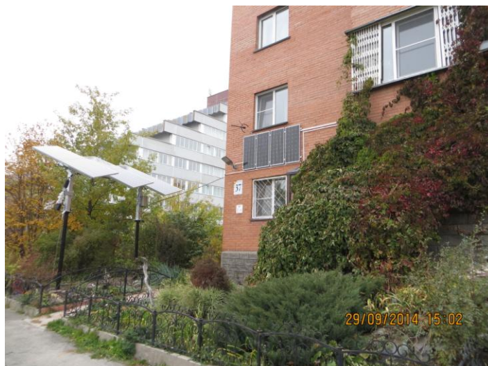
Рис. 14. Солнечная станция, установленная на трекере и фасаде жилого дома.
