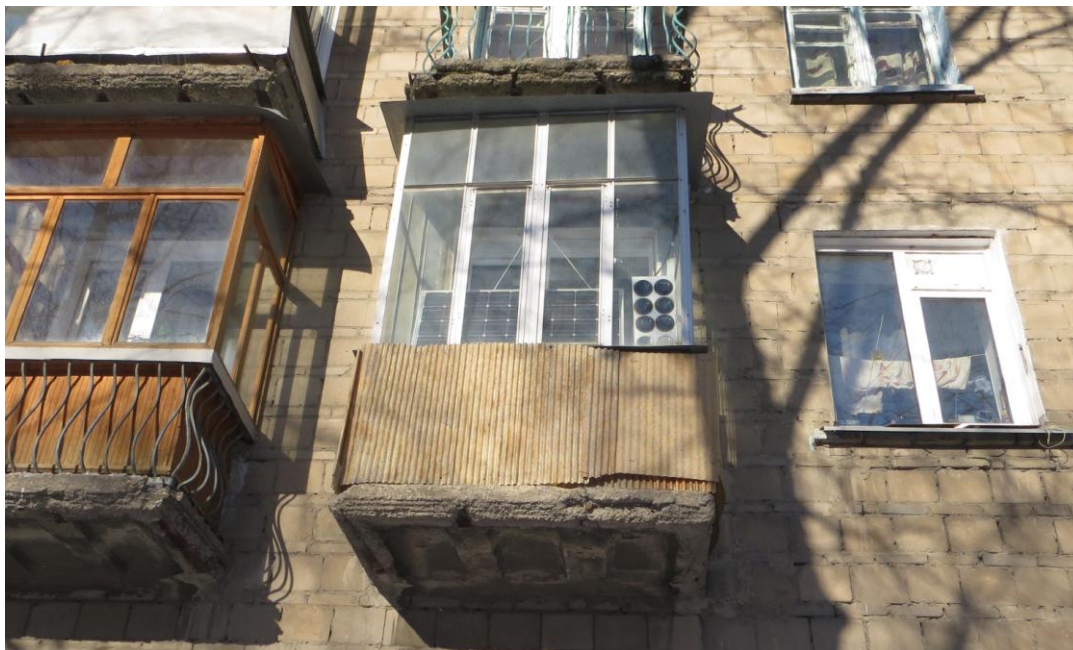
Рис. 13. Получение электрической энергии от энергии солнца в многоэтажном жилом доме, г. Новосибирск.
