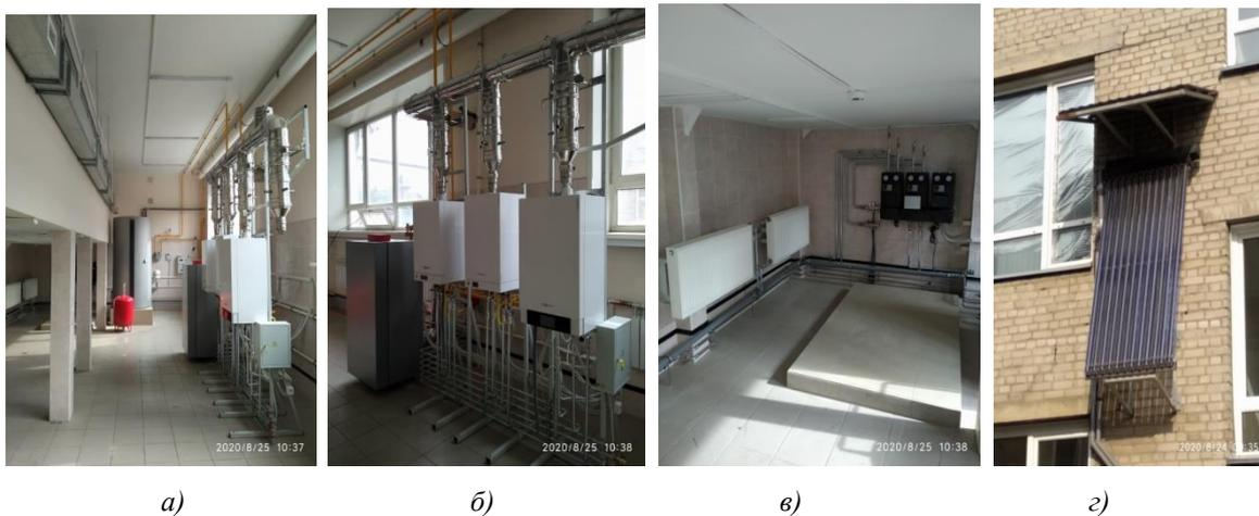
Рисунок 1. Учебный класс: а) -общий вид; б) -газовые котлы; в) -приборы систем отопления; г) -вакуумный солнечный коллектор.
