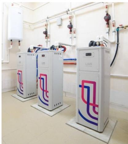
*Рис. 1. Каскад геотермальных тепловых насосов.*
