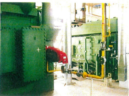
Холодильная станция на базе двух машин с огневым обогревом (природный газ) АБХМ-1500Тс мощностью 3000 кВт для линии розлива минеральной воды в ООО "Карачинский источник"
